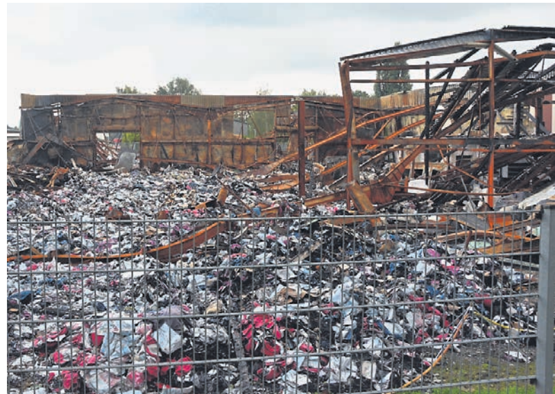
Spediteur Arno Stockhorst klagt darüber, dass der Wiederaufbau der abgebrannten Halle nicht voranschreitet.
